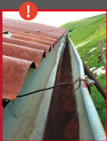
1. Verifica integrità tetto e grondaie
